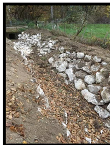
Fossé hydraulique de la Bertholière
